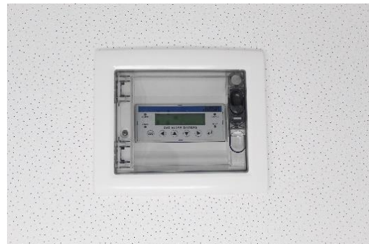
Abbildung 2: Version Türeinbau im verbauten Zustand
